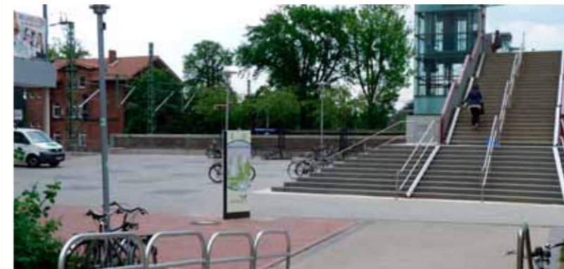
Besserer Zugang zur Bahnbrücke
