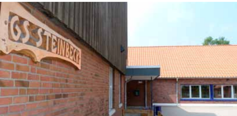
Umfangreiche Sanierung der Schulen
